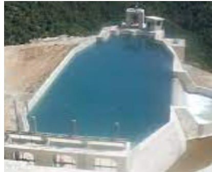
Resim 2.4. Yükleme havuzu
