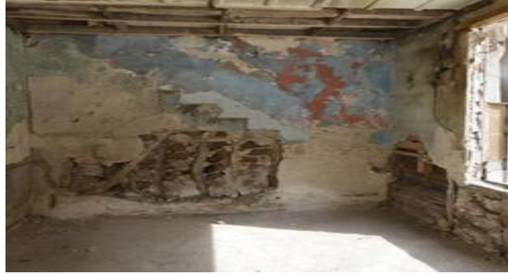
Fotoğraf 3.8. Veli Paşa Hanı'nda kullanılan kerpiç ve tuğla malzeme
