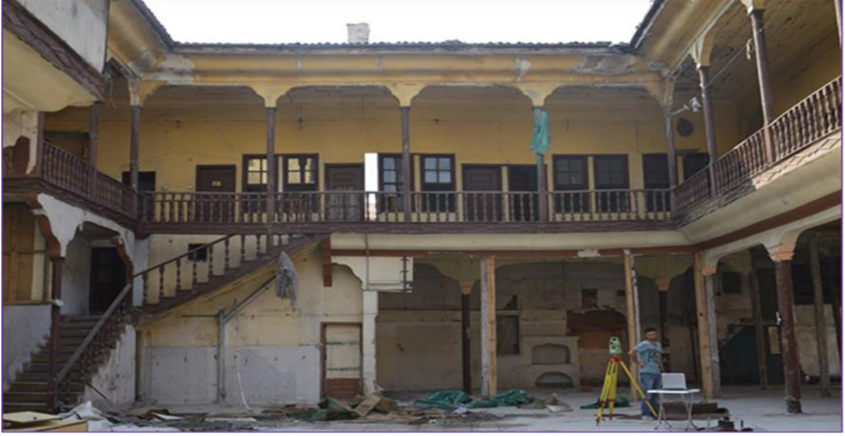
Fotoğraf 3.29. İç güney cephedeki merdiven
