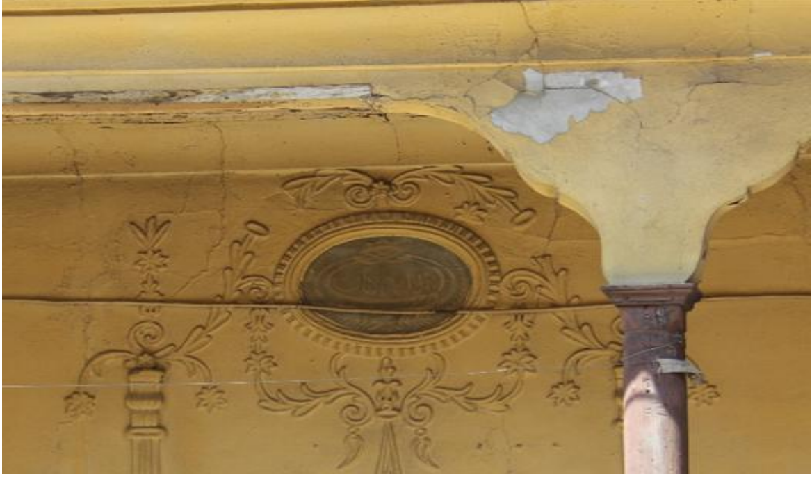
Fotoğraf 3.4. Yapının batı kanadında avluya bakan koridor duvarındaki alçı kabartma madalyon
