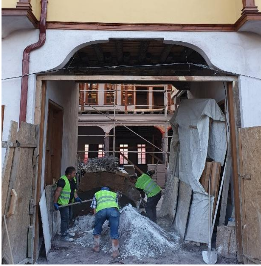
Fotoğraf 3.32. Doğu cephesinde bulunan hana giriş koridoru
