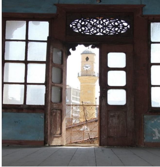
Fotoğraf 3.40. Anadolu Oteli kısmında ikinci kattan balkona çıkılan kapı
