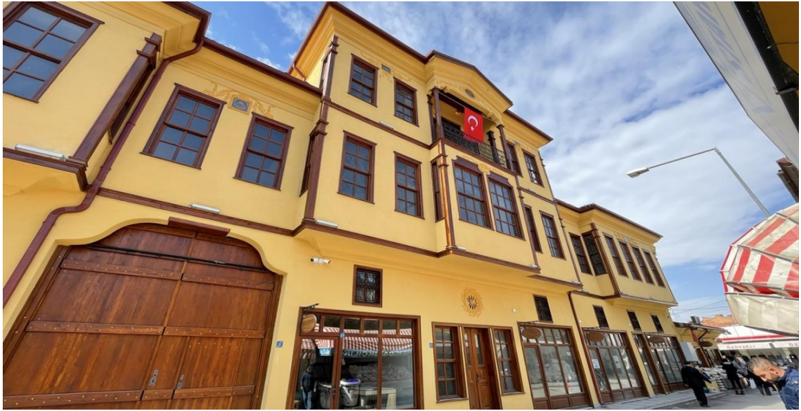
Fotoğraf 3.56. Veli Paşa Hanı doğu cephe bugünkü görünüm (2022)
