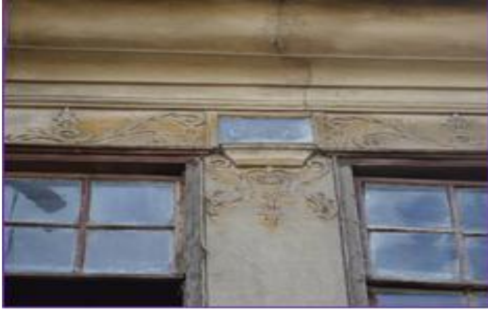
Fotoğraf 3.41. Veli Paşa Hanı doğu cephesinden süslemeleri (balkonun sağı)
