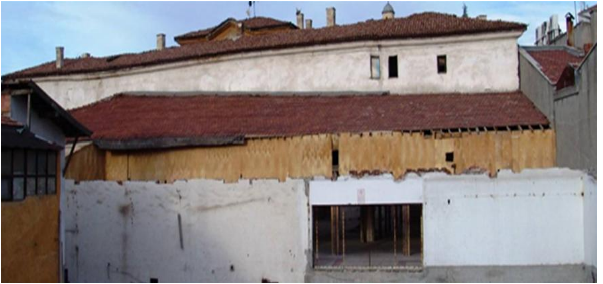
Fotoğraf 3.27. Veli Paşa Hanı dış batı cephesi
