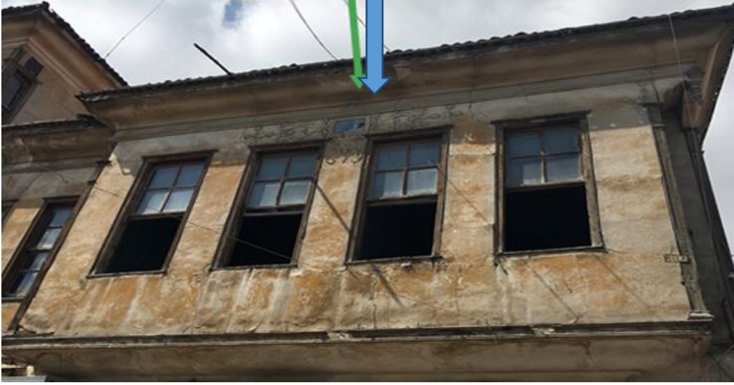
Fotoğraf 3.48. Doğu cephe en sağ dört pencere arasında kalan dış süsleme unsurları
