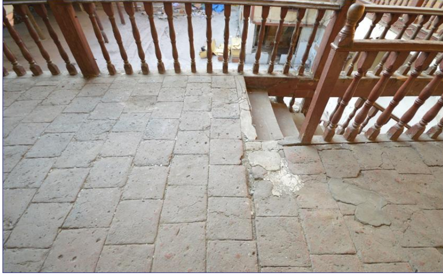
Fotoğraf 3.9. Veli Paşa Hanı tuğla döşeme balkon zemini
