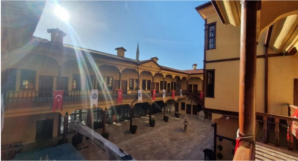
Fotoğraf 3.58. Veli Paşa Hanı iç avlu görünüm (2022)
