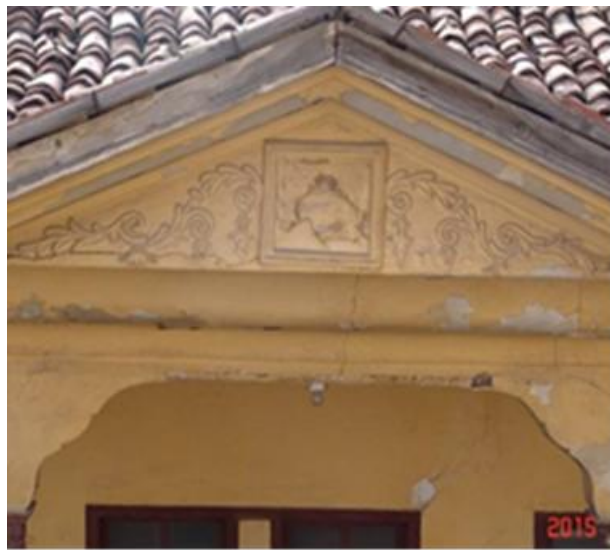
Fotoğraf 3.16. İç batı cephe çatı alınlığında alçı kabartma süsleme
