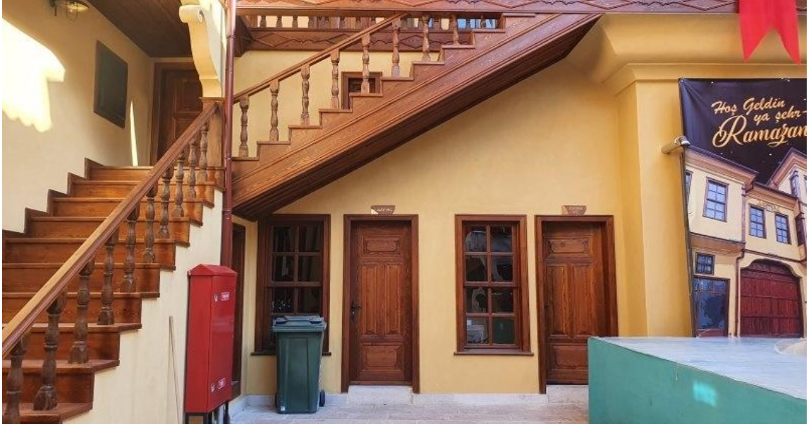
Fotoğraf 3.62. İç güney cephedeki merdiven (2022)
