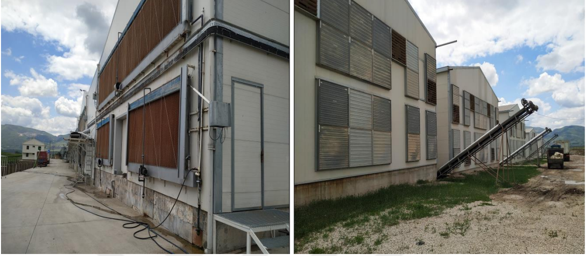
Resim 4.1. Tesisin dış görünüşü
