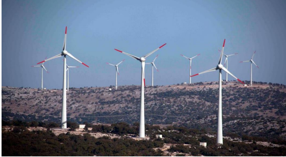
Şekil 1.9. Soma rüzgâr enerjisi santrali (Şenol 2017)
