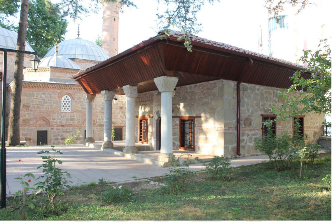
Fotoğraf 5. Sultan Hatun Türbesi Dıştan Görünüm
