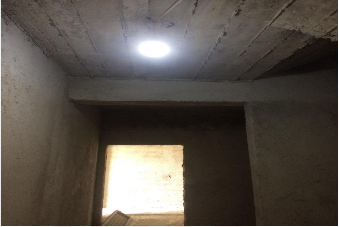
Resim 4.4. İnşaat içi aydınlatma (doğru uygulama)
