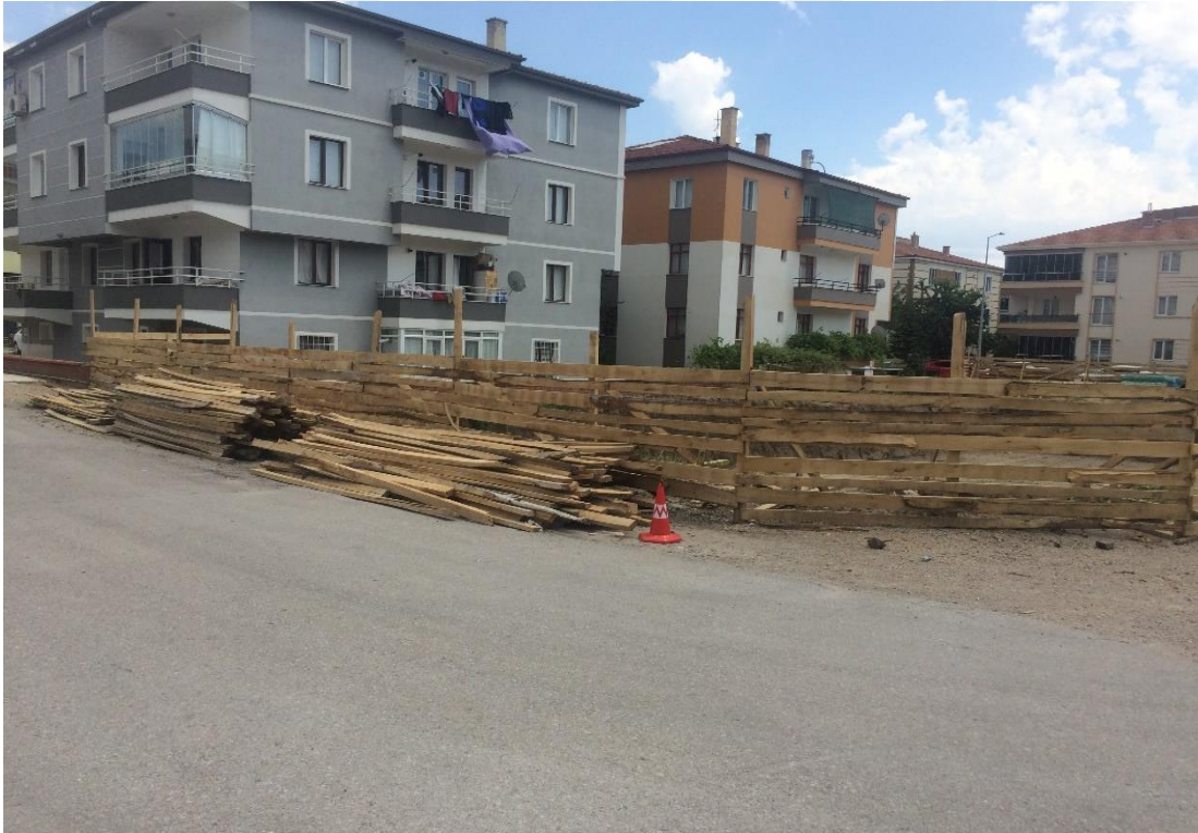
Resim 4.15. İnşaat çevresi (doğru uygulama)
