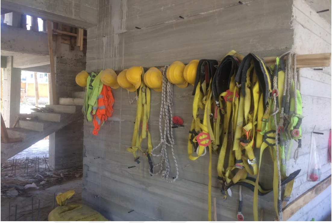
Resim 4.1. İnşaatta işçilerin kullanımı için KKD bulundurulması (doğru uygulama)
