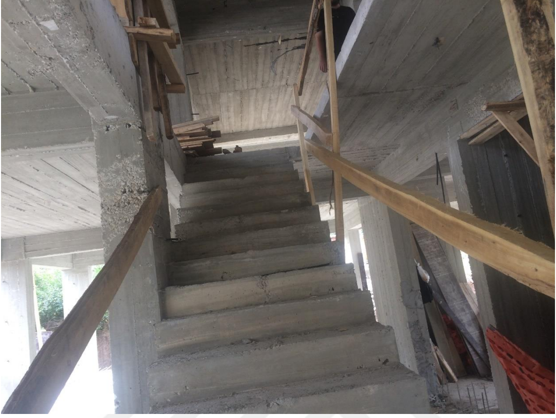
Resim 4.6. Merdivenler (dođru uygulama)
