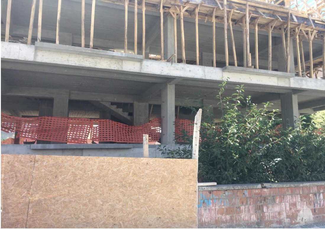
Resim 4.9. Döşemeler (doğru uygulama)
