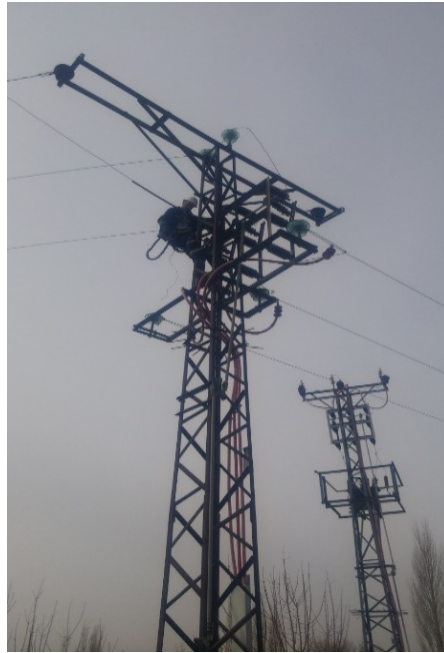
Resim 4.6. Sahada Bakım çalışması
