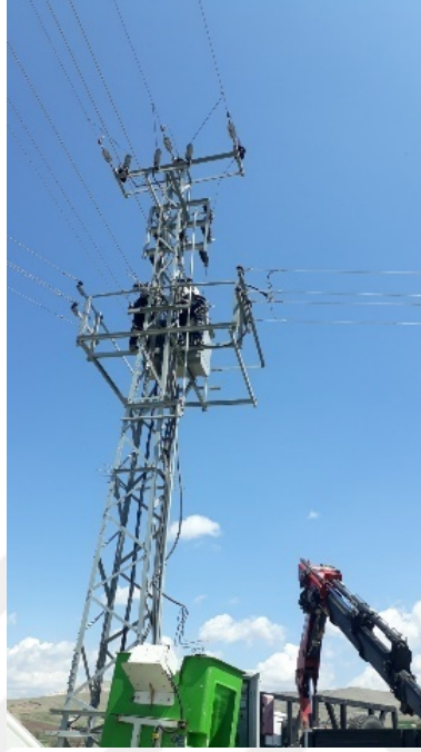
Resim 4.10. Trafo Bakımı
