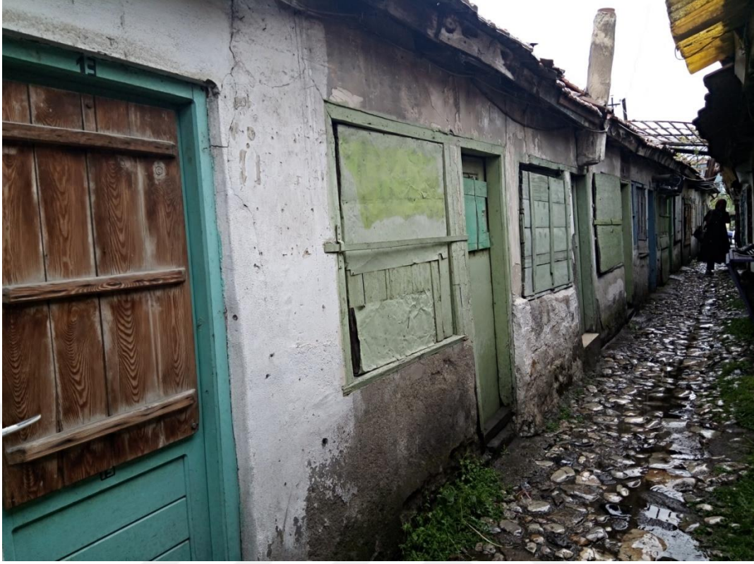
Fotoğraf 5.38. 15 no'lu dükânın ön cephe görünümü (A. Torun, 2019)
