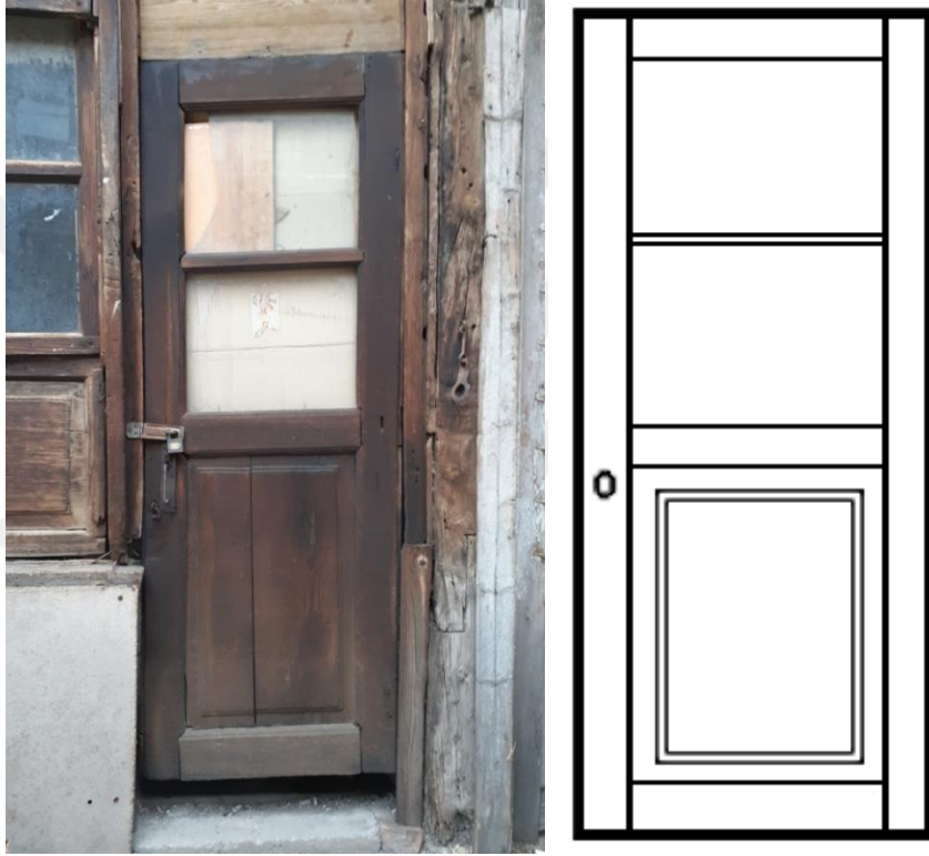
Fotoğraf 6.19. Özgünlüğünü koruduğu düşünülen kapı örneği ve çizimi (A. Torun, 2020)
