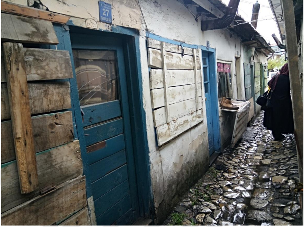
Fotoğraf 5.52. 29 no'lu dükkânın ön cephe görünümü (A. Torun, 2019)
