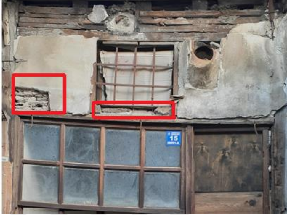
Fotoğraf 6.24. 373 no'lu adanın 15 no'lu dükkânında kullanılan kerpiç detayı (A. Torun, 2019).
