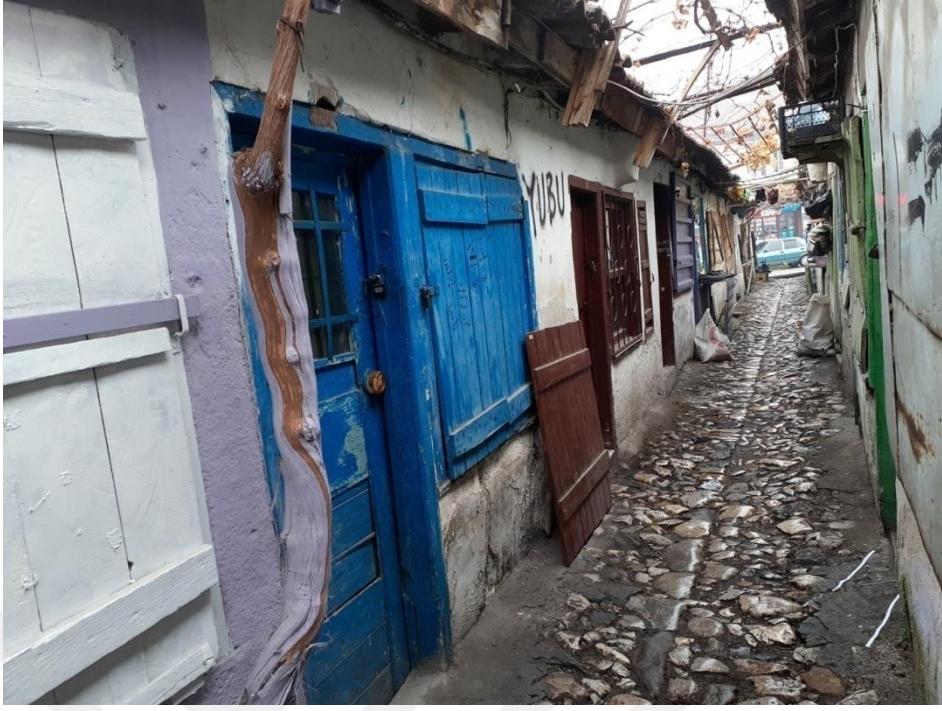
Fotoğraf 5.43. 20 no'lu dükkânın ön cephe görünümü (A. Torun, 2019)
