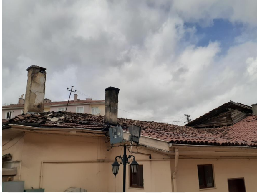
Fotoğraf 6.15. Ulu Cami dükkânlarında kullanılmış olan Osmanlı tipi kiremit ile Marsilya tipi kiremit
