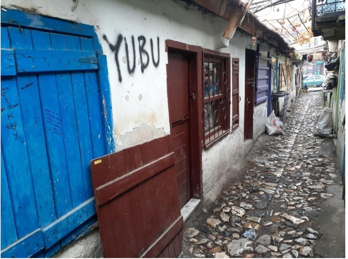
Fotoğraf 5.41. 18 no'lu dükkânın ön cephe görünümü (A. Torun, 2019)
