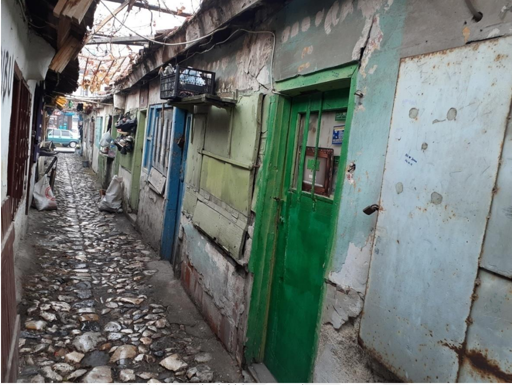
Fotoğraf 5.46. 23 no'lu dükkânın ön cephe görünümü (A. Torun, 2019)
