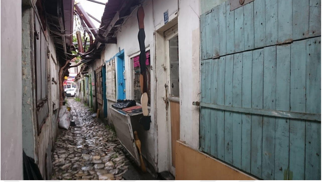
Fotoğraf 5.53. 31 no'lu dükkânın ön cephe görünümü (A. Torun, 2019)
