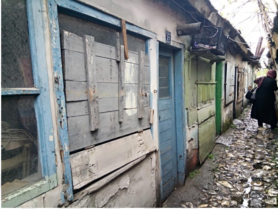
Fotoğraf 5.44. 21 no'lu dükkânın ön cephe görünümü (A. Torun, 2019)
