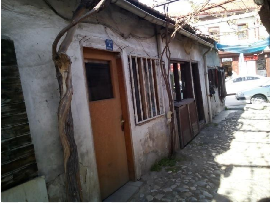
Fotoğraf 5.28. 4 no'lu dükkânın ön cephe görünümü (A. Torun, 2019)
