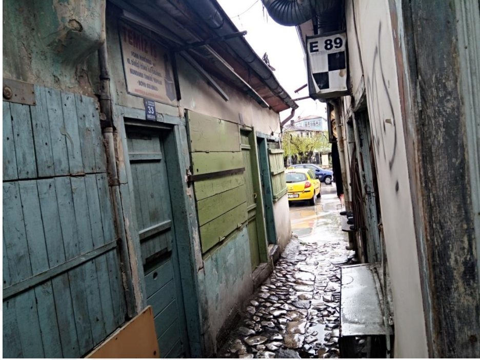
Fotoğraf 5.55. 35 ve 37 no'lu dükkanların ön cephe görünümü (A. Torun, 2019)
