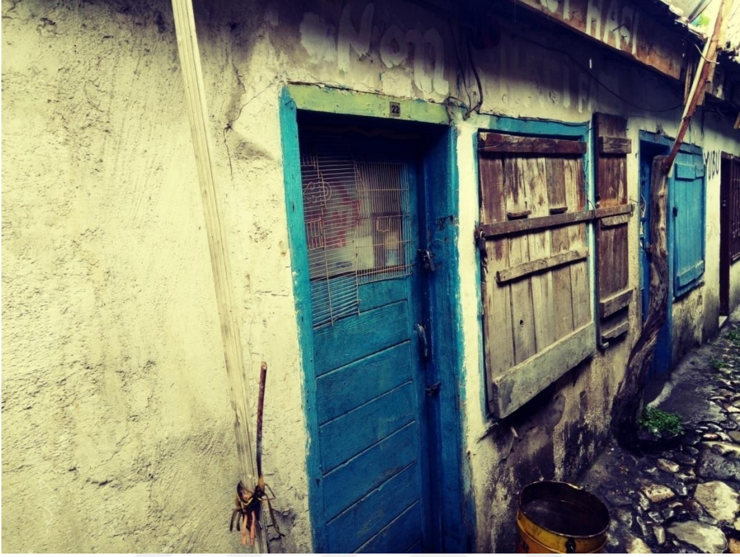
Fotoğraf 5.45. 22 no'lu dükkânın ön cephe görünümü (A. Torun, 2019)
