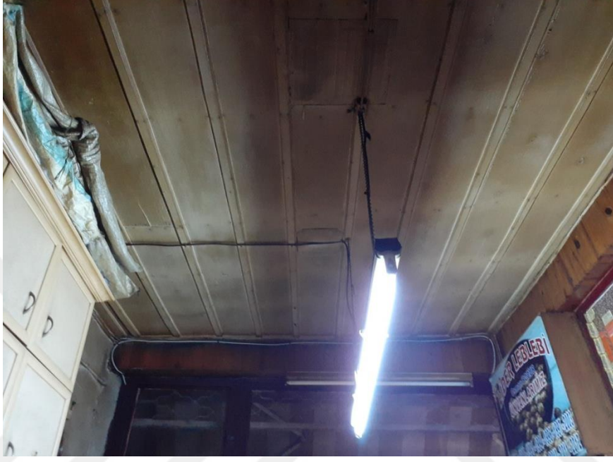
Fotoğraf 6.9. 14 no'lu dükkânın tavan döşemesi (A. Torun, 2019)
