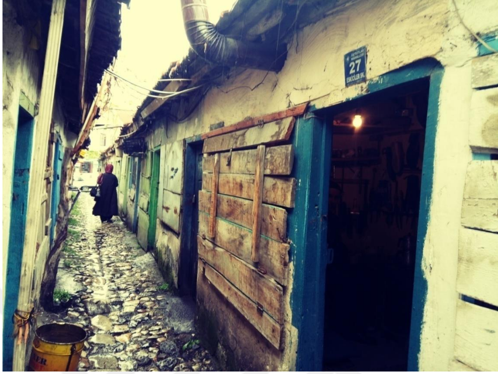
Fotoğraf 5.50. 27 no'lu dükkânın ön cephe görünümü (A. Torun, 2019)
