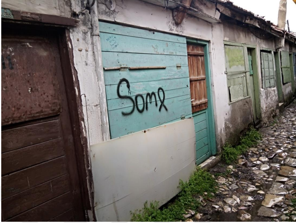
Fotoğraf 5.36. 13 no'lu dükkânın ön cephe görünümü (A. Torun, 2019)
