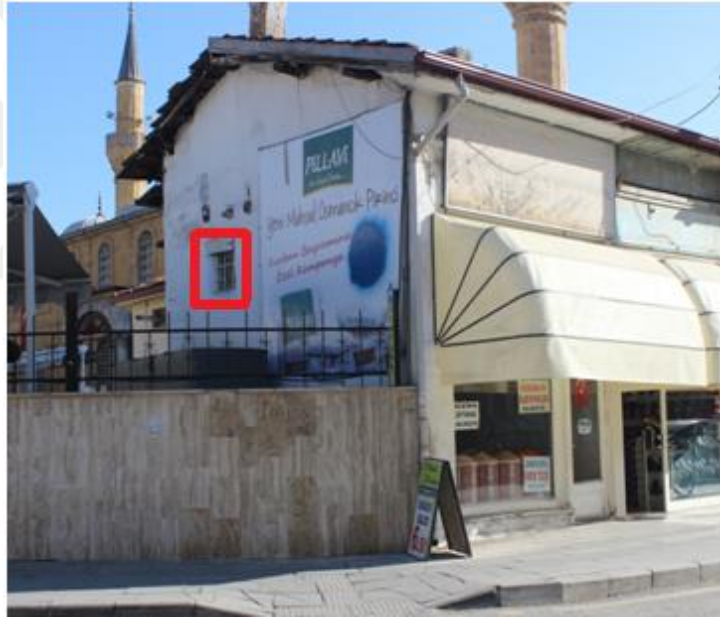
Fotoğraf 6.13. 34 A no'lu dükkânın kuzey cephesi ve küçük pencere detayı (A. Torun, 2019)
