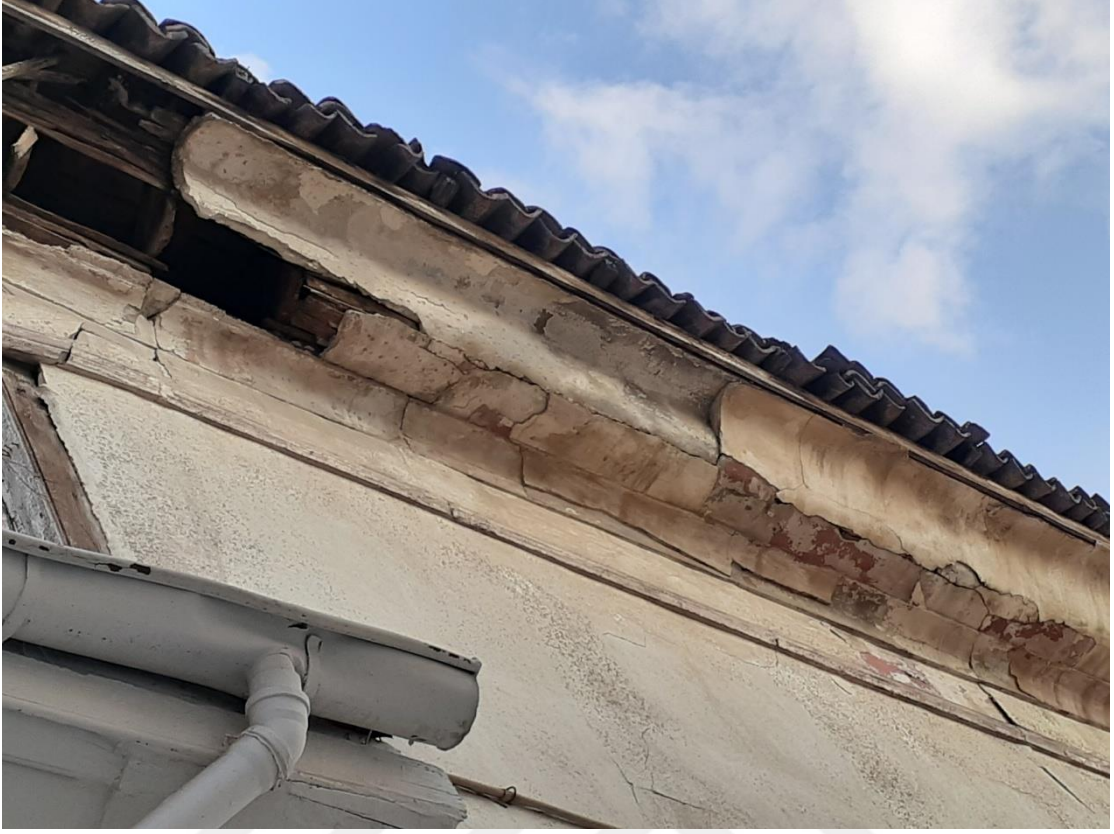
Fotoğraf 5.13 (b). Hürriyet meydanı 6 no'lu dükkânın saçak altı detayı (A. Torun, 2019)
