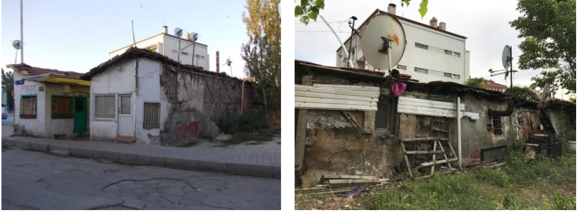
Fotoğraf 6.40. Çorum Dikiciler Arastası kuzey cephesi 2012 ve 2019 görünümü (E. Keskin Arşivi)
