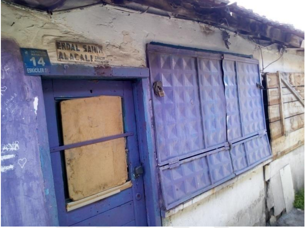
Fotoğraf 5.37. 14no'lu dükkânın ön cephe görünümü (A. Torun, 2019)
