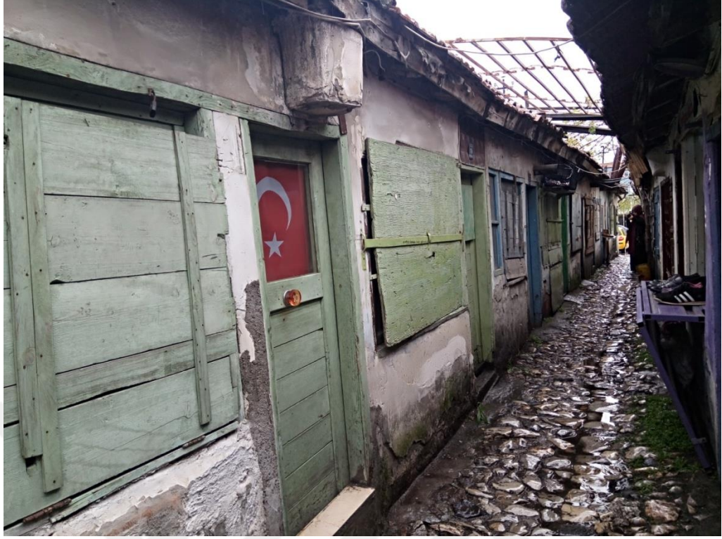
Fotoğraf 5.42. 19 no'lu dükânın ön cephe görünümü (A. Torun, 2019)
