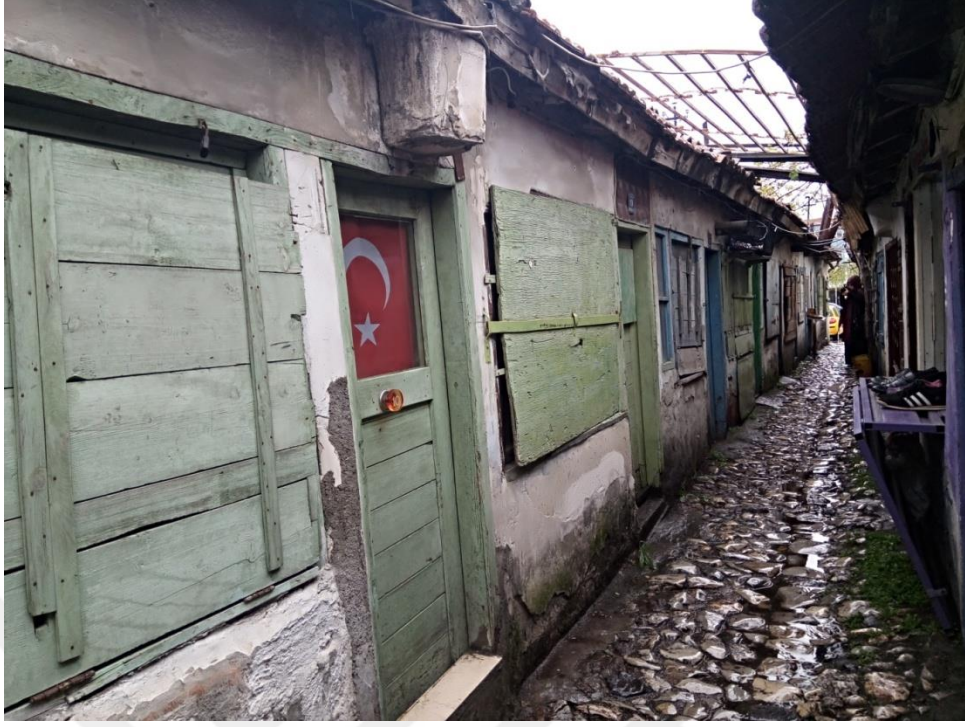
Fotoğraf 5.40. 17 no'lu dükkânın ön cephe görünümü (A. Torun, 2019)
