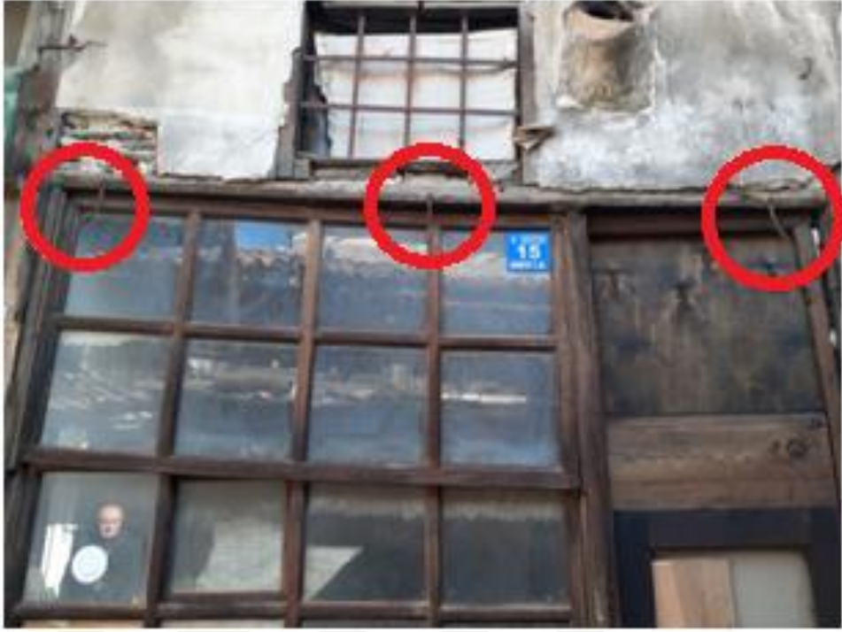
Fotoğraf 6.22. 373 no'lu adanın 15 no'lu dükkânının özgün kepenk bağlantı yerleri (A. Torun, 2020)
