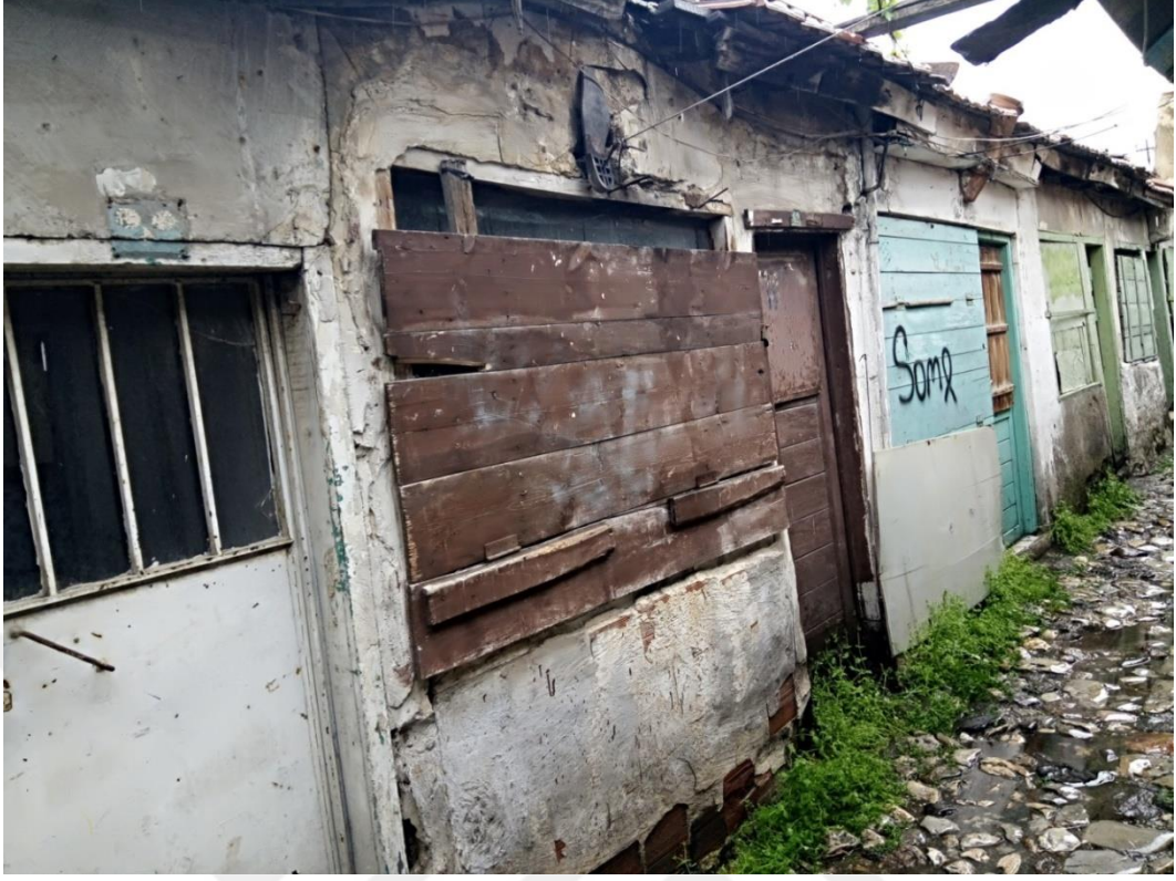
Fotoğraf 5.35. 11 no'lu dükkânın ön cephe görünümü (A. Torun, 2019)
