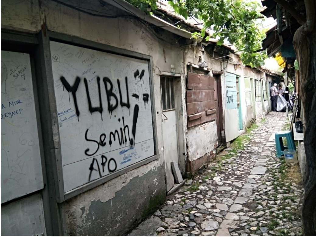
Fotoğraf 5.33. 9 no'lu dükkânın ön cephe görünümü (A. Torun, 2019)
