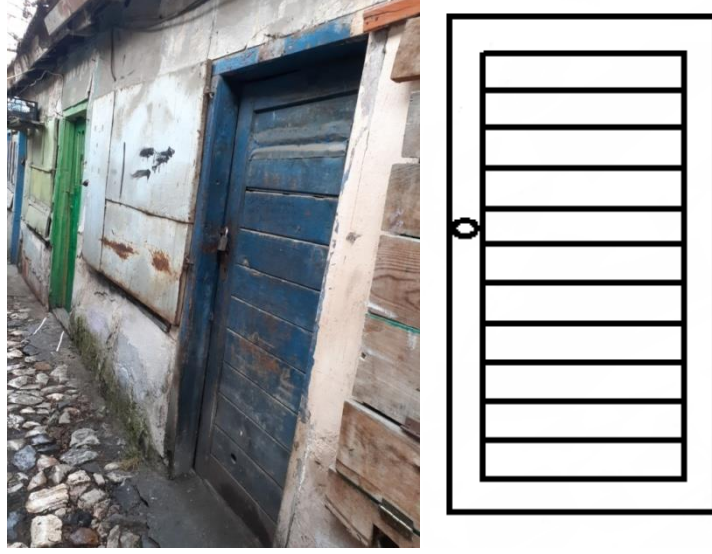
Fotoğraf 6.35. 25 no'lu dükkânın özgün kapısı ve çizimi (A. Torun, 2019)
