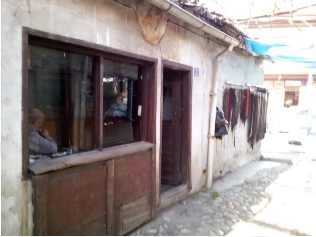
Fotoğraf 5.27. 2 no'lu dükkânın ön cephe görünümü (A. Torun, 2019)
