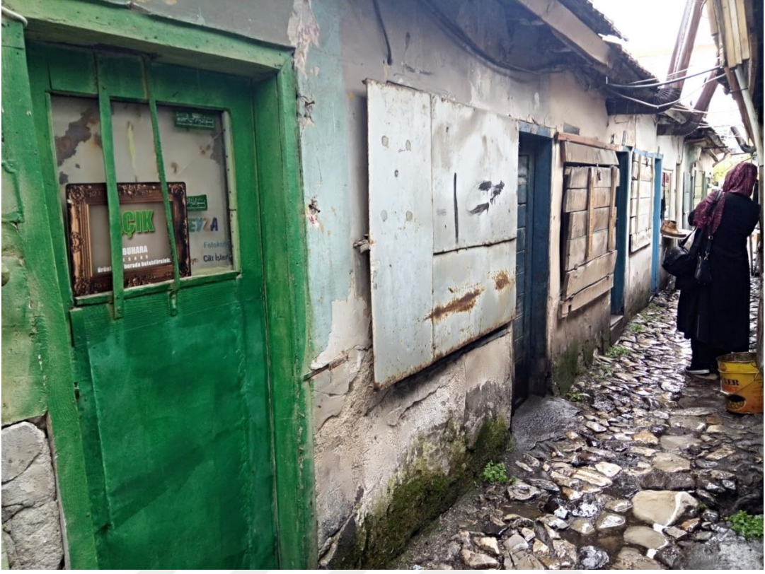
Fotoğraf 5.48. 25 no'lu dükkânın ön cephe görünümü (A. Torun, 2019)
