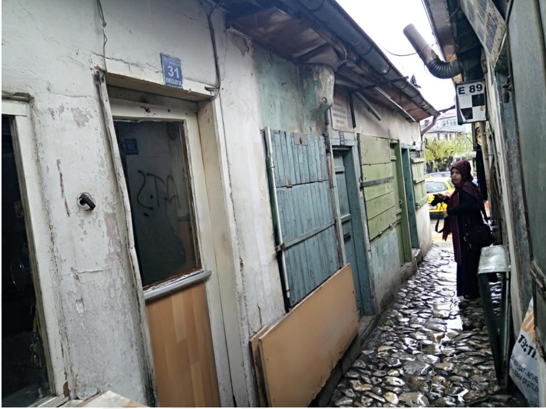
Fotoğraf 5.54. 33 no'lu dükkânın ön cephe görünümü (A. Torun, 2019)
