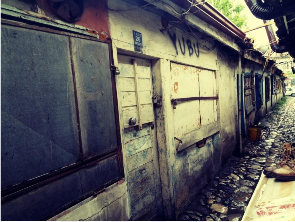
Fotoğraf 5.49. 26 no'lu dükkânın ön cephe görünümü (A. Torun, 2019)
