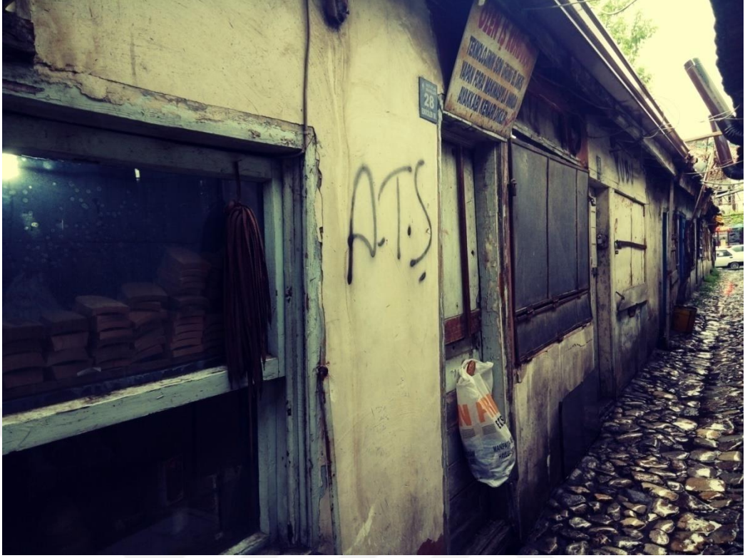
Fotoğraf 5.51. 28 no'lu dükkânın ön cephe görünümü (A. Torun, 2019)
