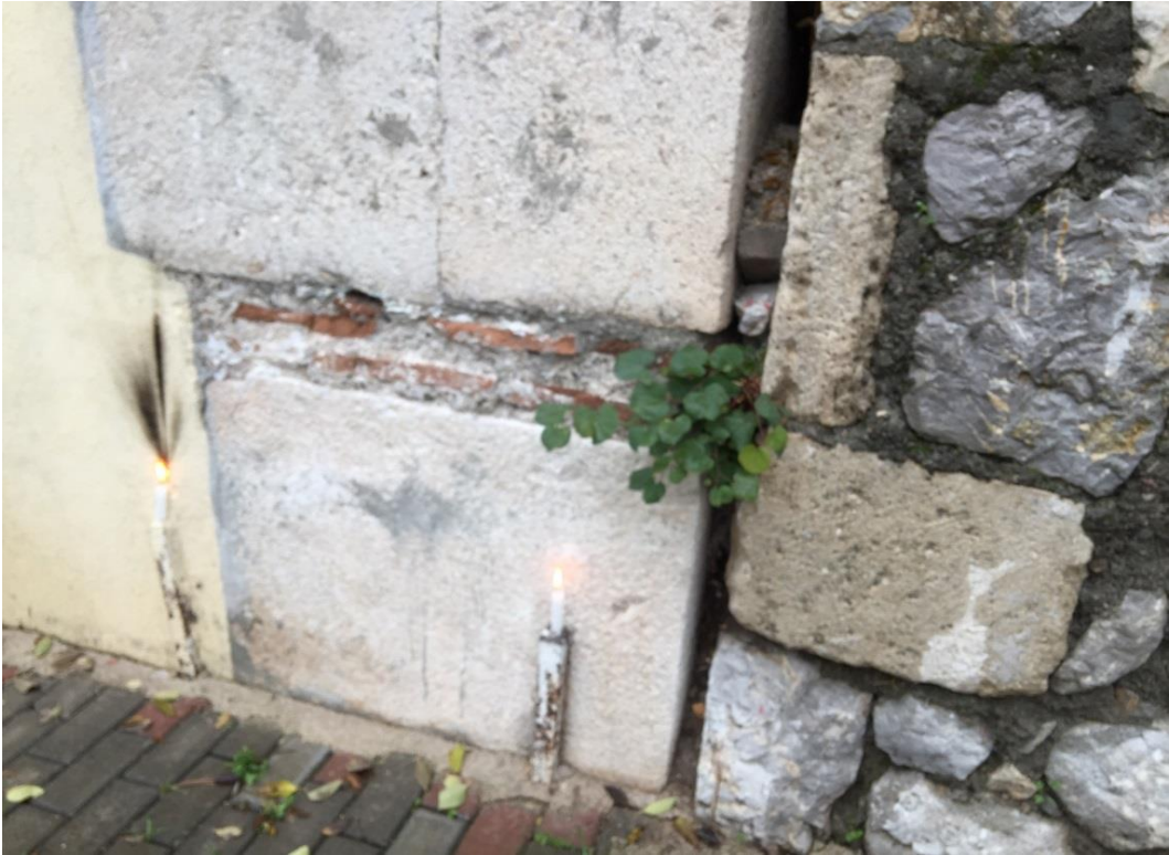
Resim 3.2. Şücaeddin Pir İlyas Türbesi Duvarının Dış Kısmında Yanan İki Mum
