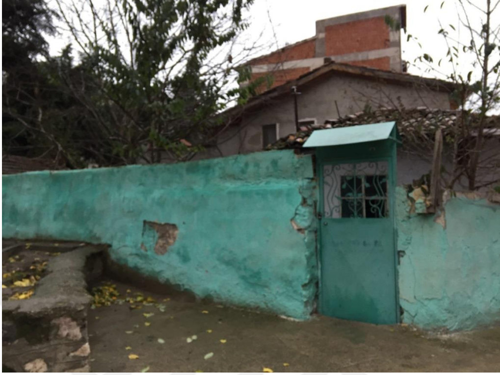
Resim 3.7. Ehli Hatun Türbesi Bahçe Duvarı ve Kapısı
