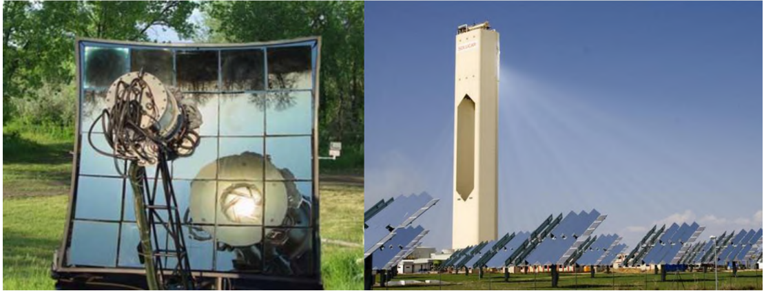
Şekil 2.1. Tek noktaya odaklı güneş ile hidrojen üretebilen iki proses
